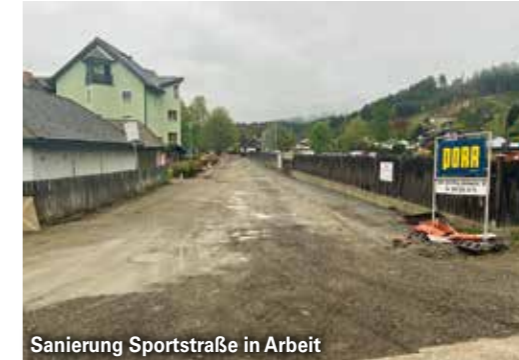
Sanierung Sportstraße in Arbeit
