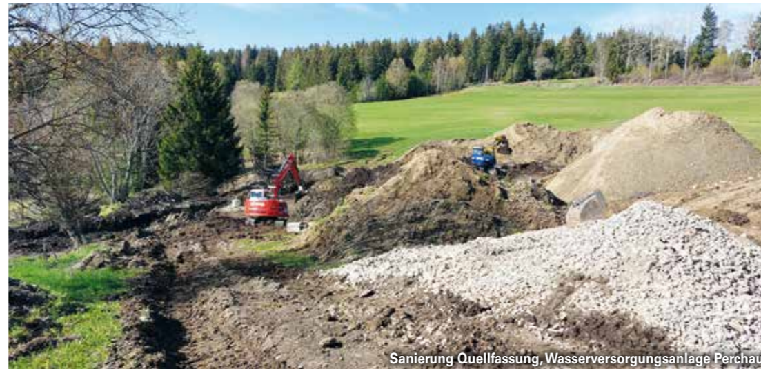
Sanierung Quellfassung, Wasserversorgungsanlage Perchau
