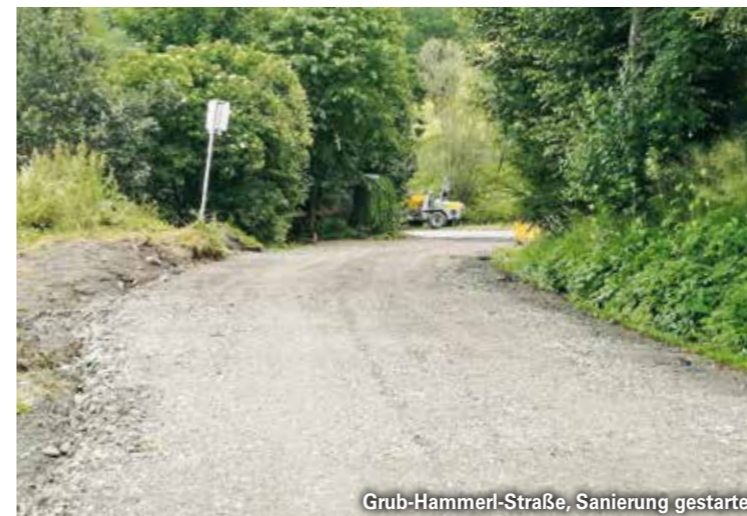
Grub-Hammerl-Straße, Sanierung gestartet
