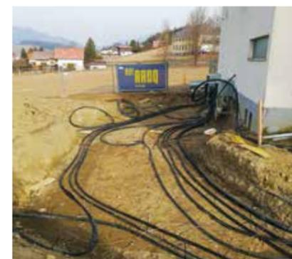
fangreiche Verkabelungsarbeiten auf der Hochspannungsebene, von der Alt- auf die Neuanlage, statt. Der letzte Schritt wird dann die Implementierung vom Fernwirk- und Leitsystem sein, wobei auch die Rundsteueranlage ebenfalls erneuert wird.
